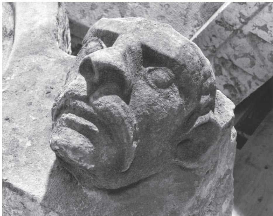
FACE SUD DE LA TOUR LANTERNE ; CLAVEAU AVEC MASCARON EXÉCUTÉ LORS DE LA RESTAURATION CONDUITE PAR VIOLLET-LE-DUC, MOLASSE, 1872-1877. DÉPOSÉ EN 1988 [photo Fibbi-Aeppli]
