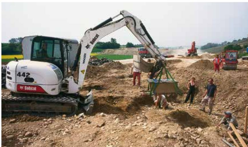
◀ Transport du coffrage grâce à une petite pelle mécanique (photo AC, Christian Falquet)
